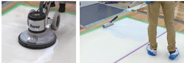
リノリウムやラバーフロア、化学床などの弾性(レジリエント)床材の重度な汚れや傷みなど、定期清掃では手に負えなかった状況を、張り替えせずカラーリノベーションによって復元させ、さらに耐久性のある床面へと変貌させます。張り替えるより安価、床そのものが一新するため、お客様への提案メニューに最適です。
